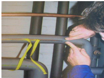
Gedämmte Heizungsrohre
